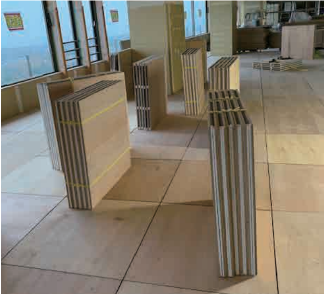
タイル下地施工及び納材現場
